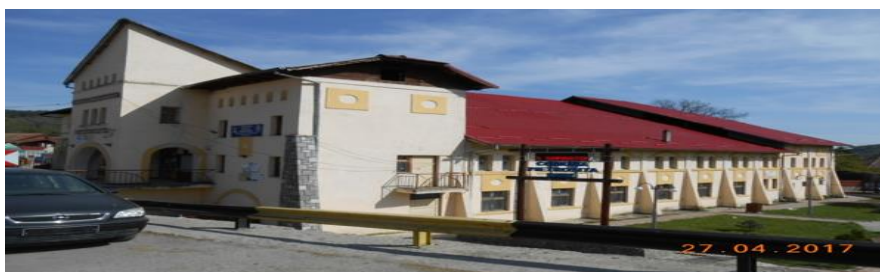
Foto: Vedere spre latura de sud-vest dinspre parc
